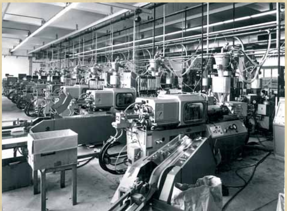
1970 lieferte Luger die ersten Netstal -Spritzgießmaschinen an Greiner Packaging , die nach dem Ausbau der Spritzgießproduktion 1974 um die erste vollautomatische Materialförderanlage Österreichs nachgerüstet wurde, geliefert vom Luger -Partner motan . Foto: Luger Privatarchiv
