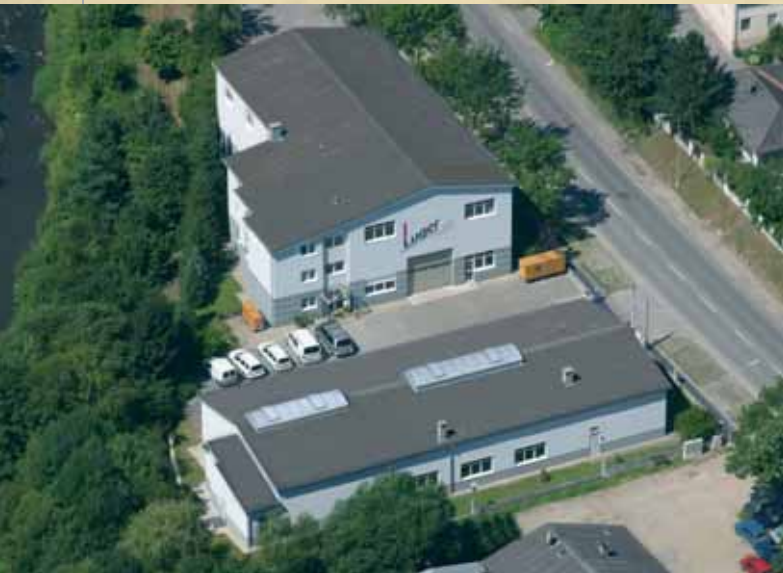
Die 1987 neu gebaute Luger-Firmenzentrale in Purkersdorf bei Wien. Von hier aus werden Kunststoffmaschinen und gesamte Verarbeitungssysteme in die Länder Österreich, Ungarn, Tschechien und die Slowakei verkauft und gewartet. Foto: Luger
