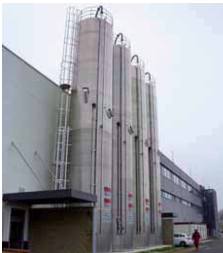
Angeliefertes Material wird in vier Doppelkammersilos gelagert.
